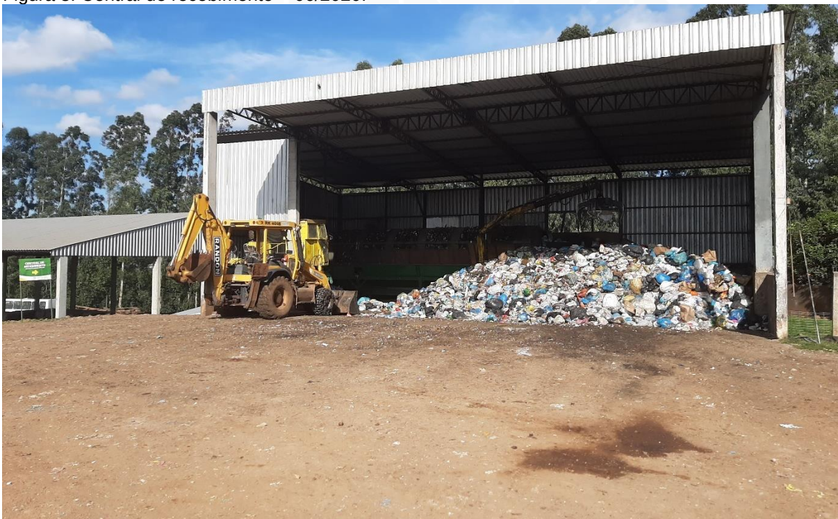
Figura 3: Central de recebimento – 06/2020.
