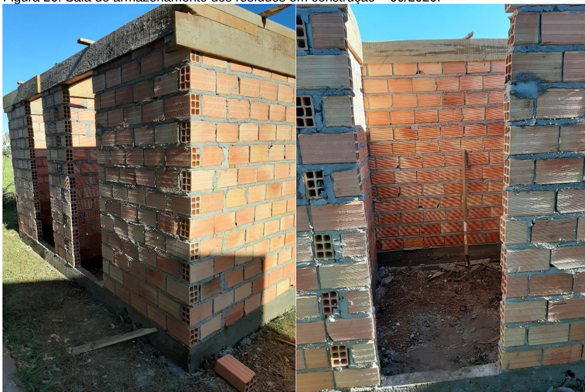
Figura 26: Sala de armazenamento dos resíduos em construção – 06/2020.
