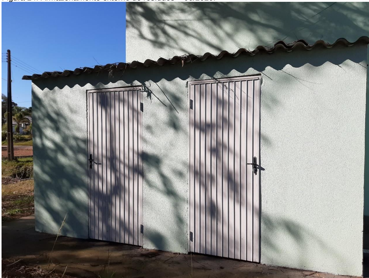
Figura 24: Armazenamento externo de resíduos – 06/2020.
