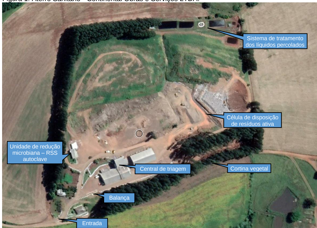
Figura 1: Aterro Sanitário - Continental Obras e Serviços LTDA.
