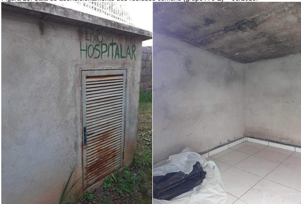
Figura 23: Sala de acondicionamento dos resíduos comuns (grupo A e E) – 06/2020.
