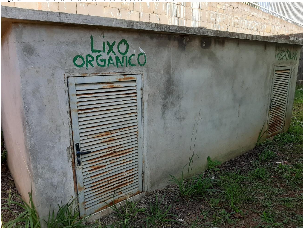
Figura 22: Armazenamento externo de resíduos – 06/2020.
