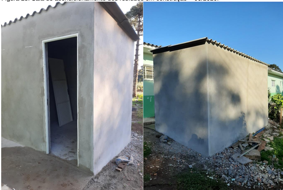
Figura 28: Sala de acondicionamento dos resíduos em construção – 06/2020.
