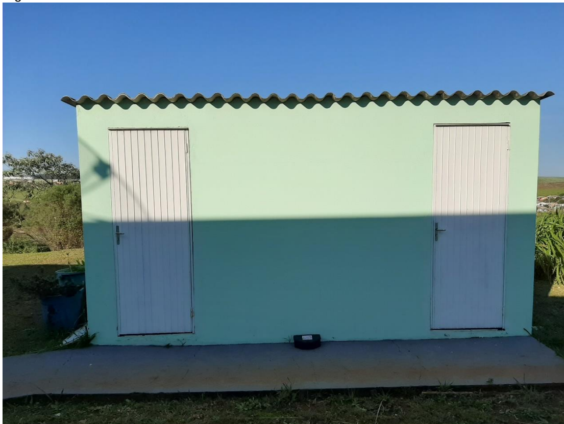
Figura 19: Armazenamento externo de resíduos – 06/2020.
