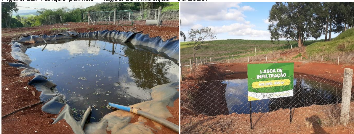
Figura 12: Tanque pulmão + lagoa de infiltração - 06/2020.
